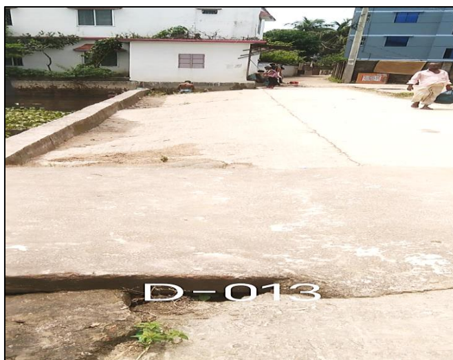
Photo , Haziganj- Drain -13
